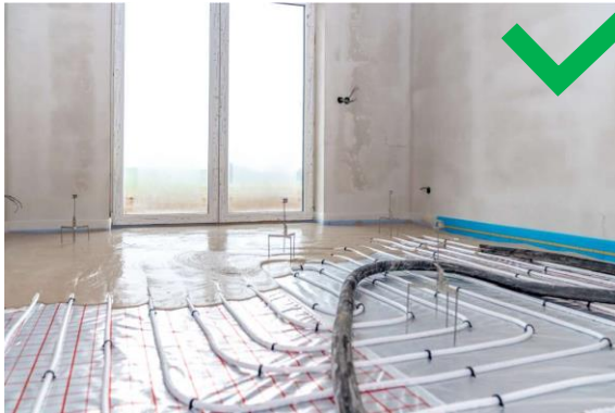
Fußbodenheizung
