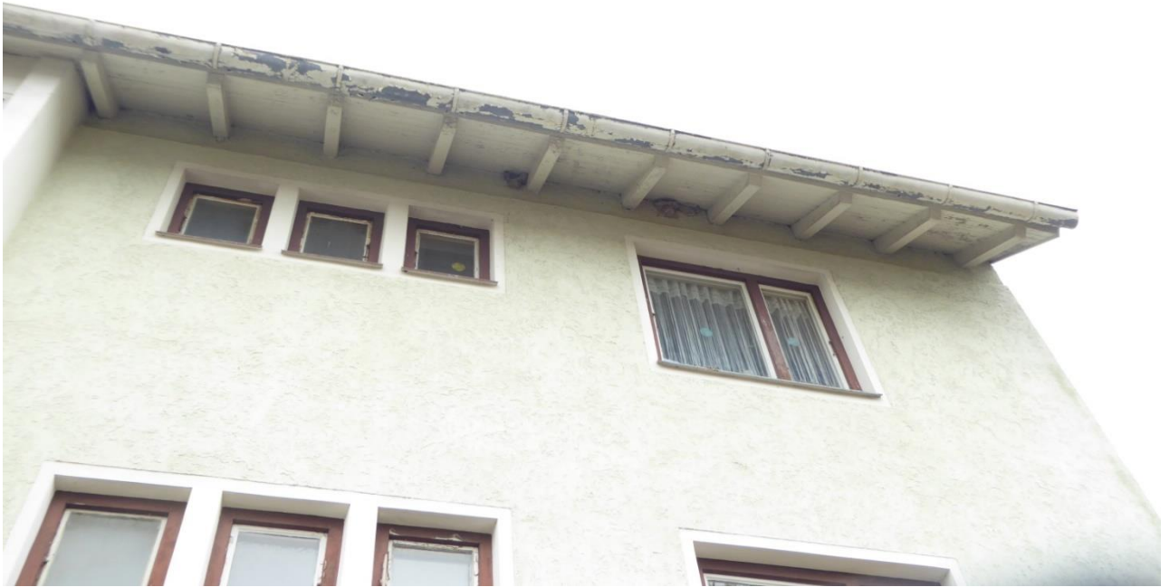
Abbildung 4: Südliches Gebäude im UG Nord mit Schwalbennestern an Ostseite
