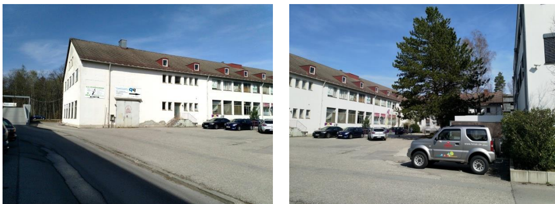
Abb. 3 und 4 Bestandsgebäude und Hofsituation mit Baumbestand, Ortseinsicht vom 02.04.2019
